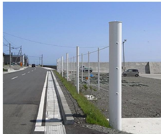
えりも港：漂流物対策工の設置状況
