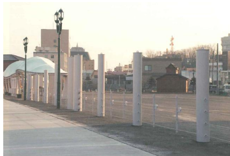
釧路港：漂流物対策工の設置状況
