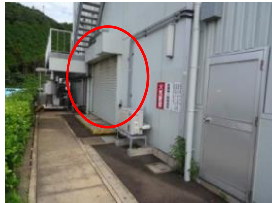
54 補助ボイラー室北側シャッター (1)
