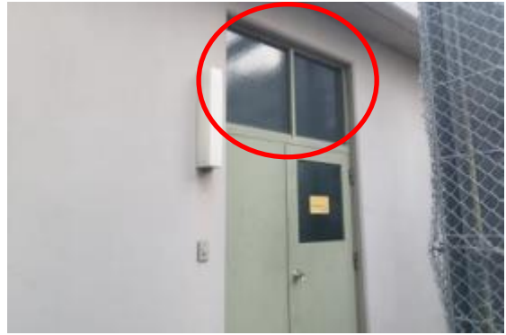
97 2号開閉所ガラス窓
