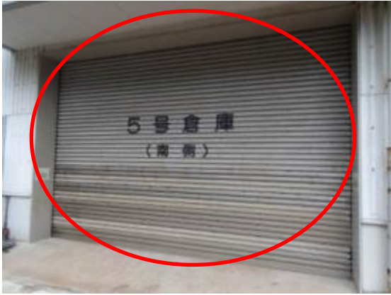
90 5号倉庫南側シャッター
