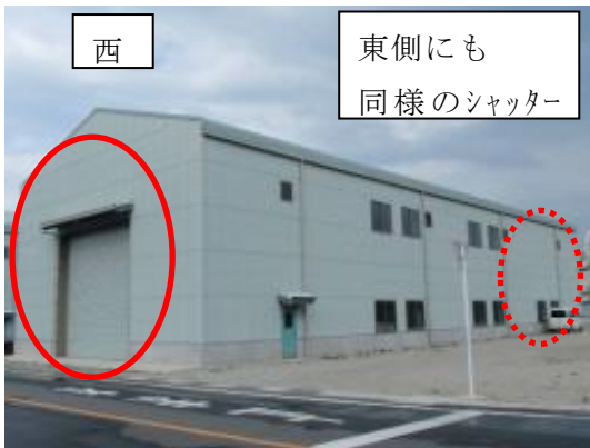
125 倉庫西，東側シャッター
