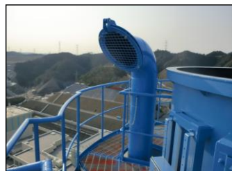
非常用ガス処理系排気管 端部状況
