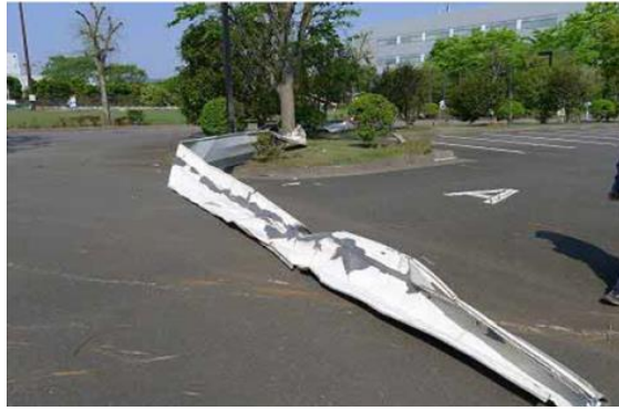
飛散した鋼板製屋根材
