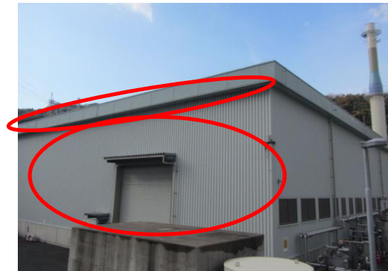
165 3号炉補助ボイラ
