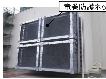
図2 竜巻防護ネットの設置イメージ
