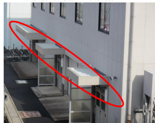
176 3号館管理事務所
