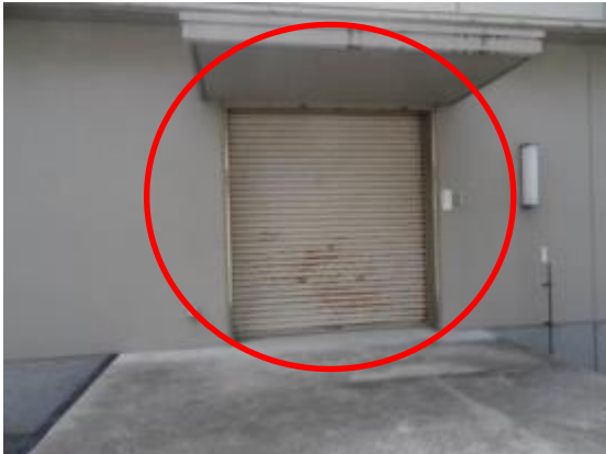
70 危険物屋内貯蔵所東側シャッター
