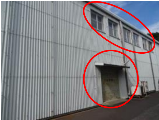
61 2号倉庫南西側シャッターガラス窓
