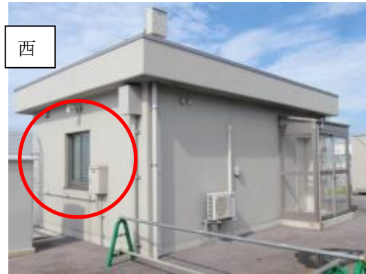
148 北口建物西側ガラス窓
