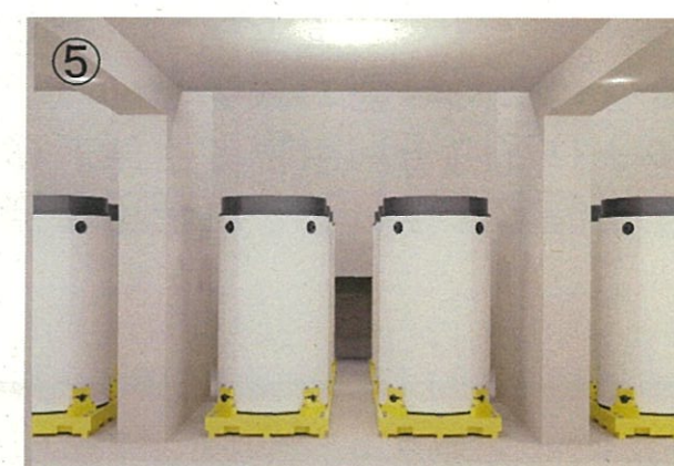
使用済燃料乾式貯蔵建屋内での乾式キャスク取り扱いイメージ図
