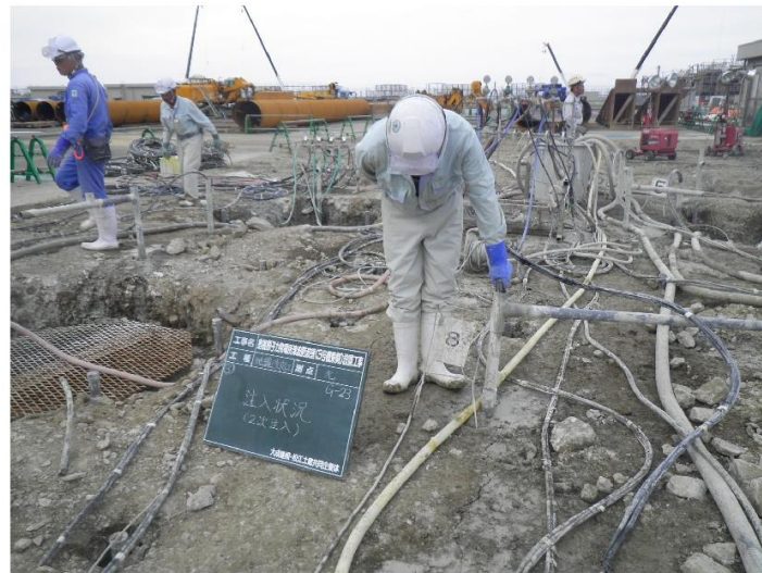
薬液注入工 状況写真(2011年撮影)
