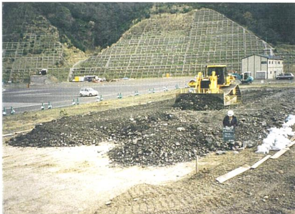
巻き出し整地状況
