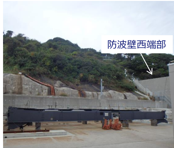
防波壁西端部 状況写真
