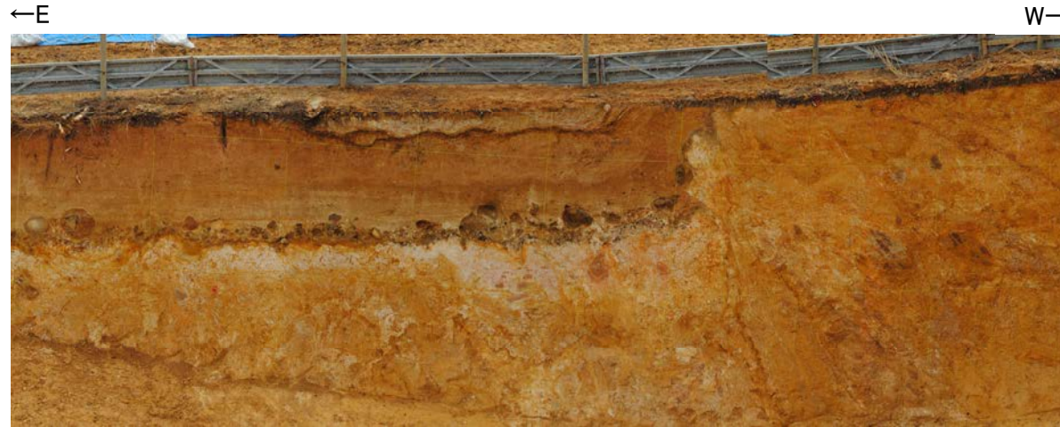
南壁面写真(断層付近)
