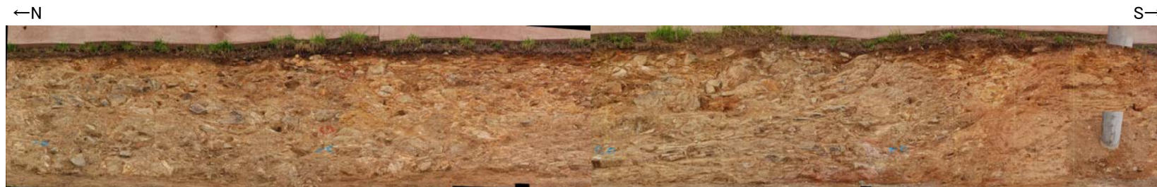
写真(35m盤法面)
