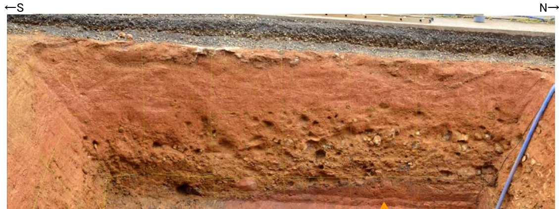
写真(駐車場南東方トレンチ 西壁面)
