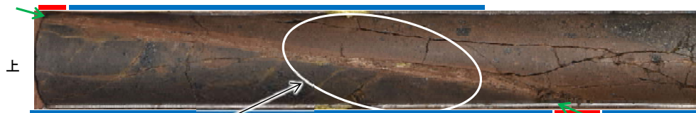
ボーリングコア写真(H-6.6-1孔)
