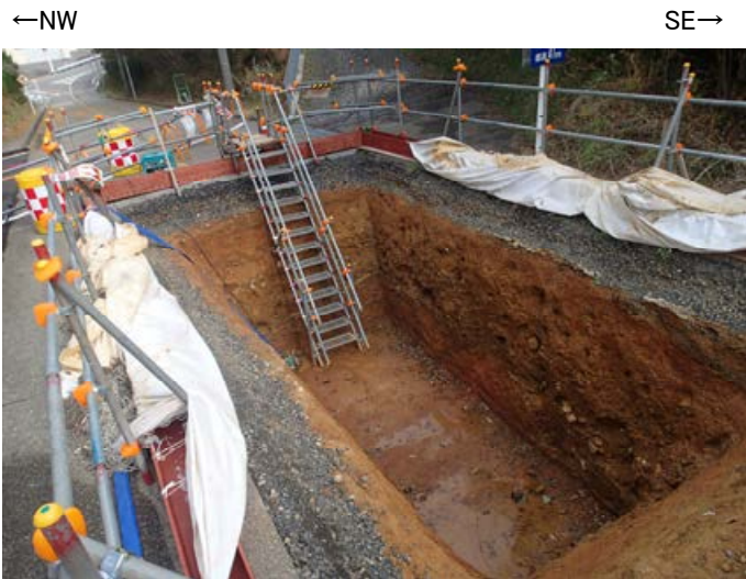
トレンチ状況写真(南西側から撮影)
