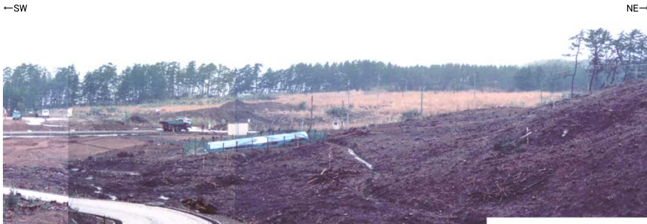
写真(樹木伐採後)
