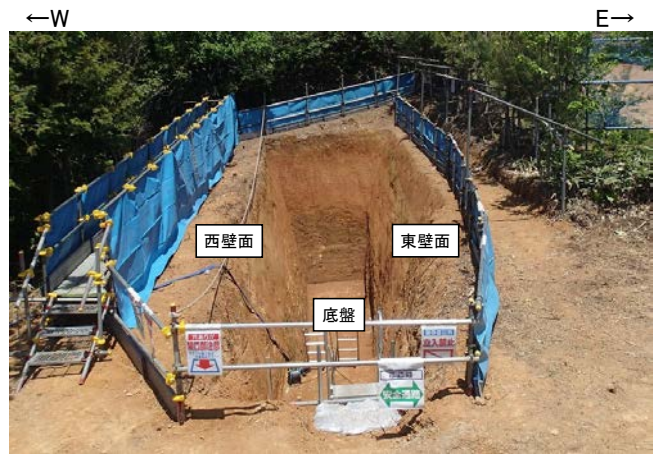
トレンチ状況写真(南側から撮影)
