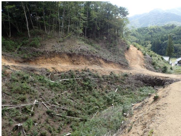
② 林道沿いの全面露頭状況
