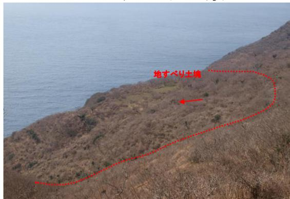
南南西に傾斜する斜面を東側から望む地形勾配の変換部が地すべり土塊の上端を示す
