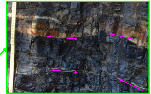
写真5-2 断層(固結)部近接写真(1)
