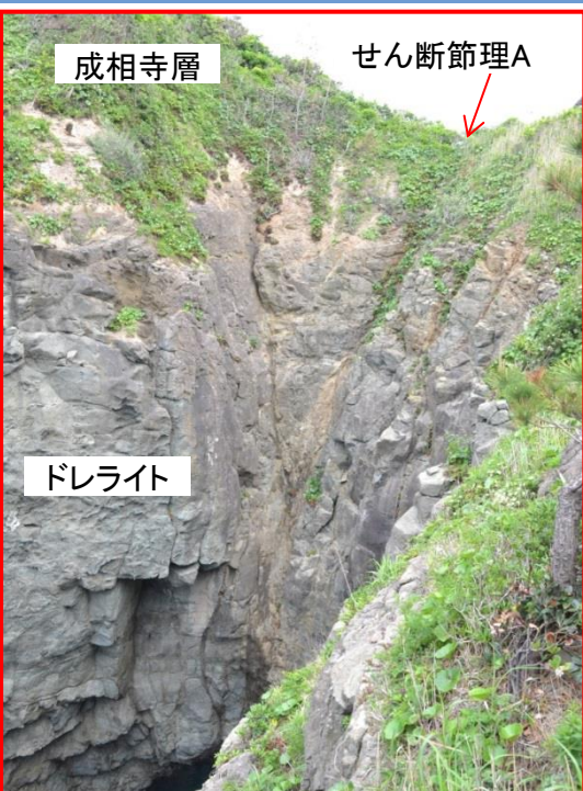
写真7-1 NNW-SSE系のせん断節理
