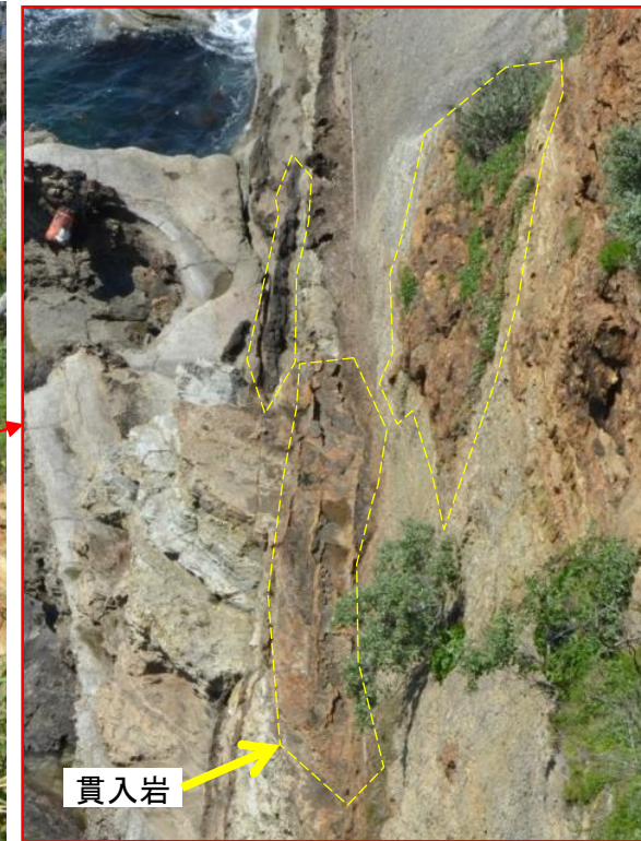
写真2-1 宮崎鼻西岸岩壁
