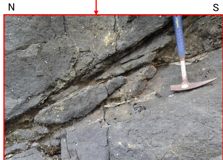
写真11-2 断層(すべり面)近接写真
