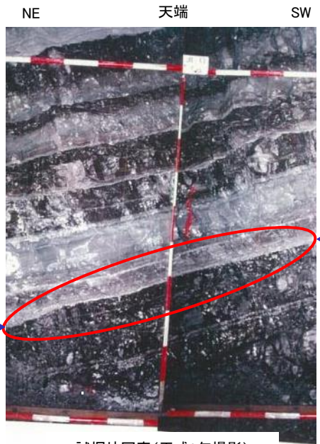
試掘坑写真(平成9年撮影)
