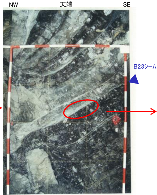
試掘坑写真(平成15年撮影)
