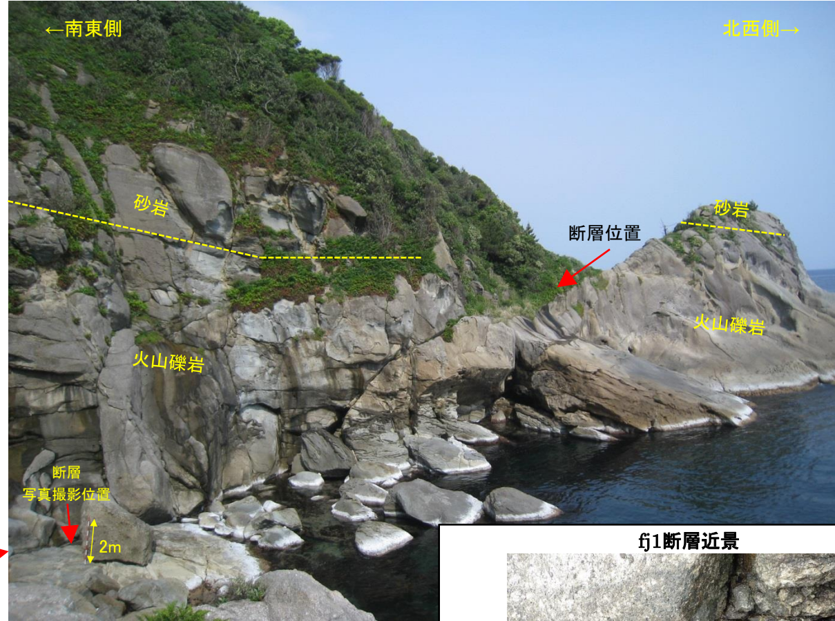
① 殿島のfj1断層全景
