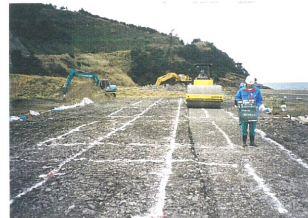
振動ローラによる転圧状況
