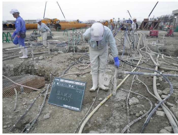
薬液注入工 状況写真(2011年撮影)
