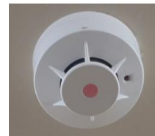
煙感知器 (光電式スポット型)
