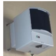
煙感知器 (光電式分離型)
