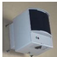
煙感知器 (光電式分離型)
