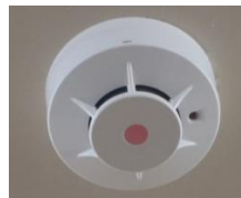
煙感知器 (光電式スポット型)
