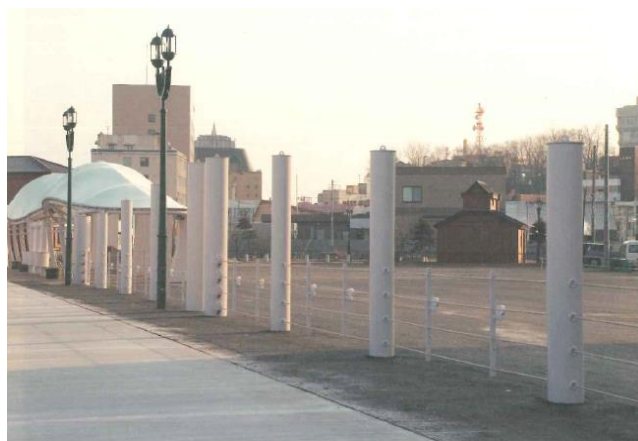
釧路港：漂流物対策工の設置状況
