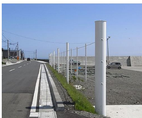
えりも港：漂流物対策工の設置状況
