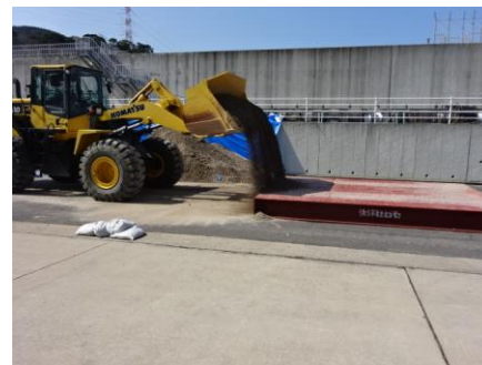
第6図 段差復旧状況
