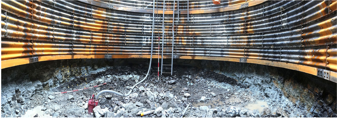
第 7. 4. 2-21 図 島根サイトの深礎杭 掘削面の写真（南側）
