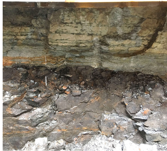
第 7. 4. 2-23 図 掘削面の近接写真
