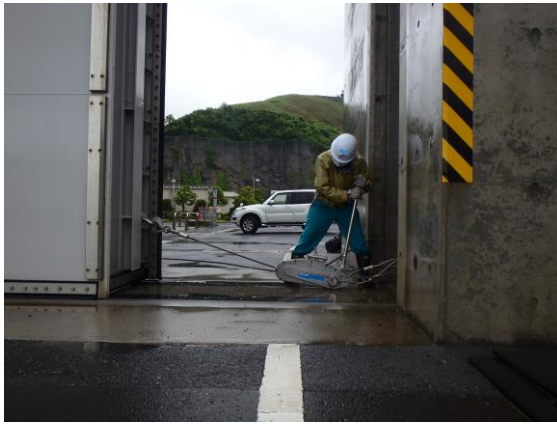
手動ウインチ操作状況
