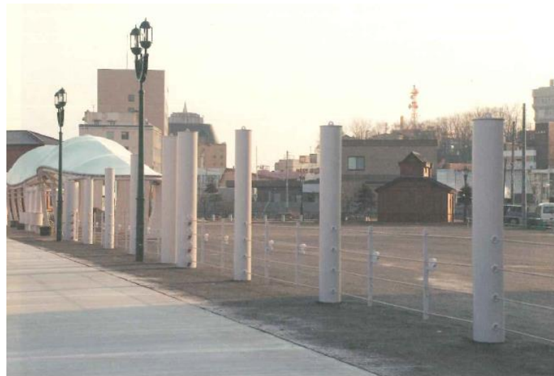
釧路港：漂流物対策工の設置状況
