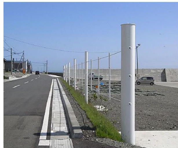
えりも港：漂流物対策工の設置状況
