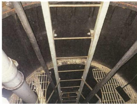
写真B 揚水井戸⑦(中間部) 2017/3/16撮影
