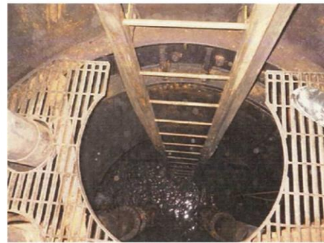
写真C 揚水井戸⑦(下段部) 2017/3/16撮影
