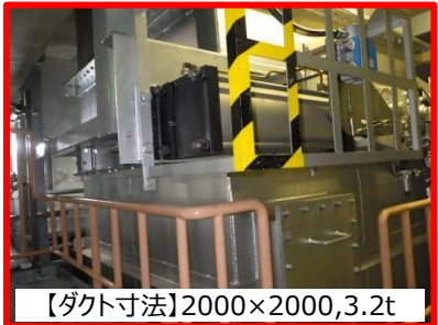
廃棄物処理建物換気系測定箇所（例）
