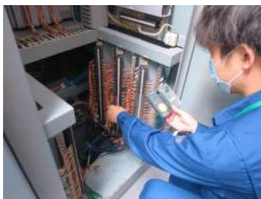
仮設計器による温度確認の一例
