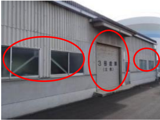
59 3号倉庫北側シャッター，ガラス窓
