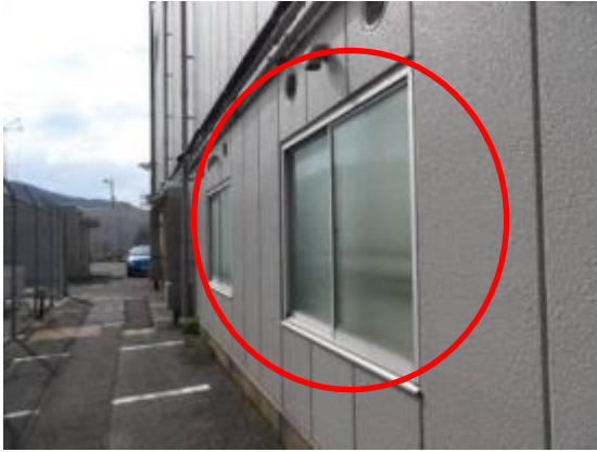
68 サイトパンカ建物ガラス窓（1）
