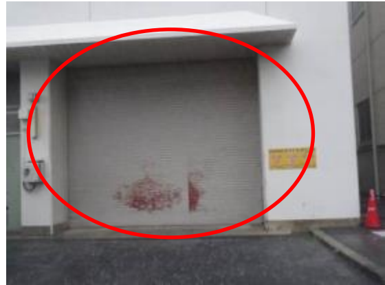
93 固体廃棄物貯蔵庫C棟西側シャッター
