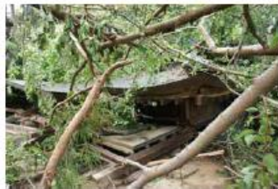
写真 3.5-18 倒木による社の倒壊
