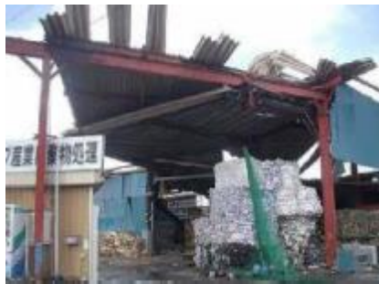
折板の損傷
