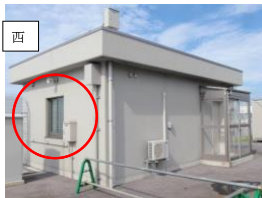
148 北口建物西側ガラス窓
