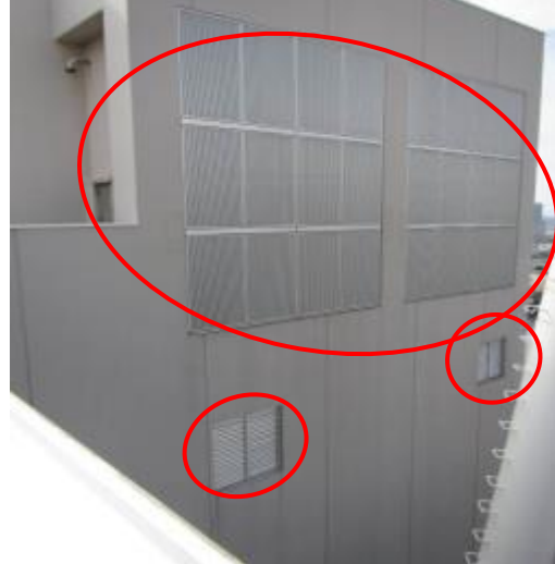
30 T/B空調換気系給気用格子
