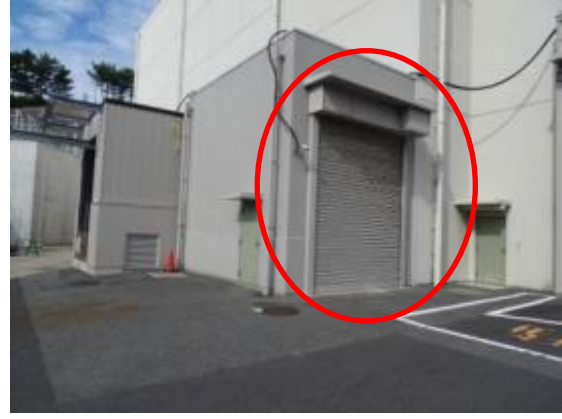
66 サイトパンカ建物南側シャッター
