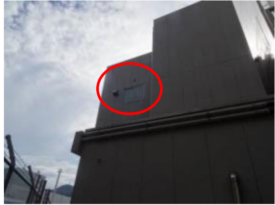
69 サイトパンカ建物ガラス窓（2）
