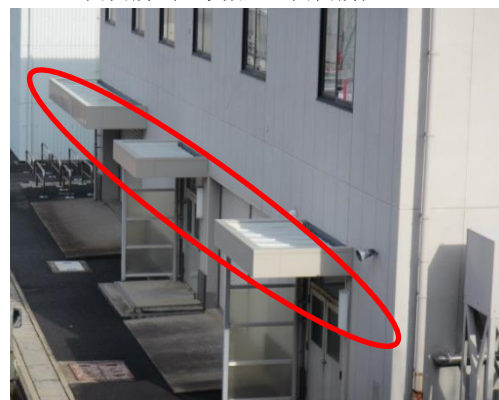
176 3号館管理事務所
