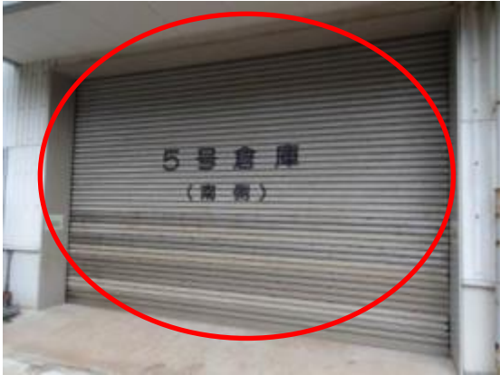
90 5号倉庫南側シャッター
