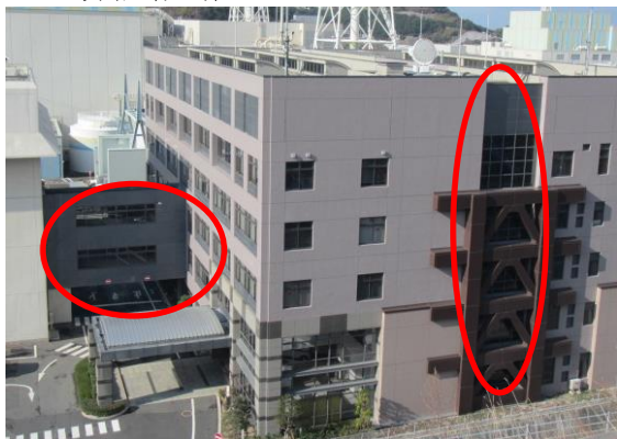
174 1号館管理事務所
