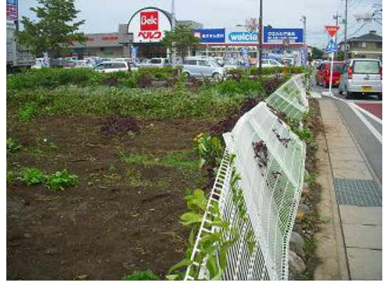
写真31 フェンスの変形
