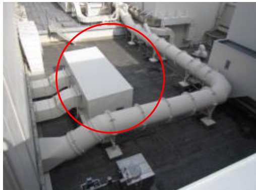
7 1号T / B空調換気系給気用格子 (屋上)
