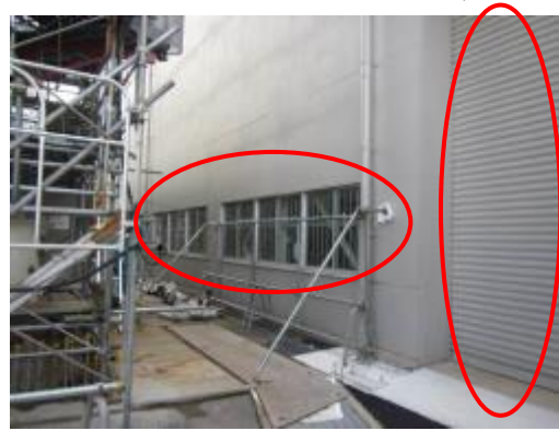
19 補機メンテナンス建物東側シャッター，ガラス窓
