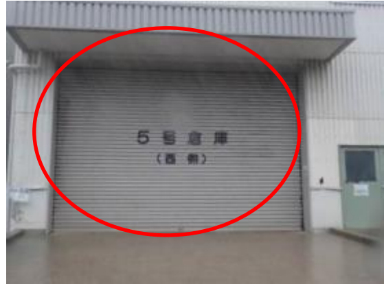
91 5号倉庫西側シャッター
