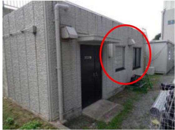
71 プロワ室ガラス窓
