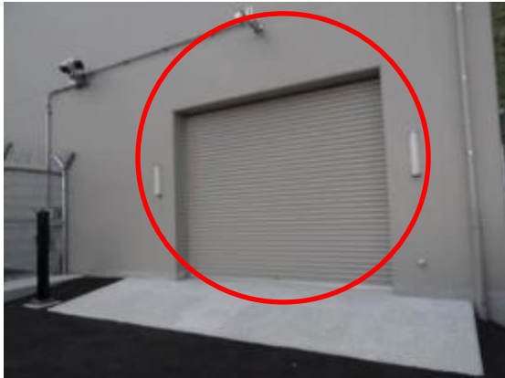
92 44m版事務所東側シャッター
