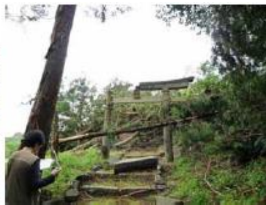
写真 3.5-16 樹木の折損と鳥居の被害
