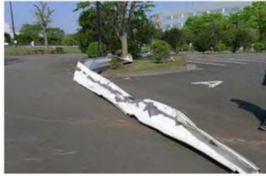
飛散した鋼板製屋根材
