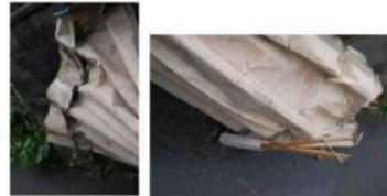
飛散した折板屋根の損傷状況
