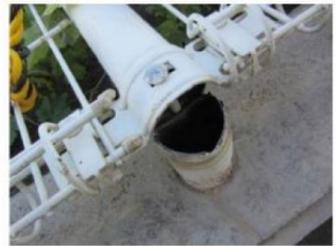
フェンス支柱部の破損
