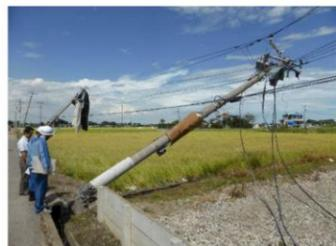
電柱の倒壊
