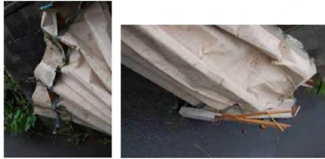
飛散した折板屋根の状況
