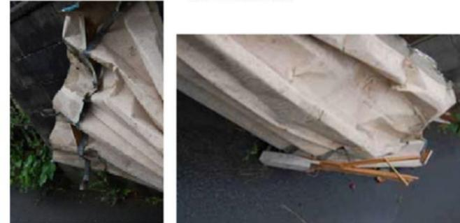
飛散した折板屋根の状況
