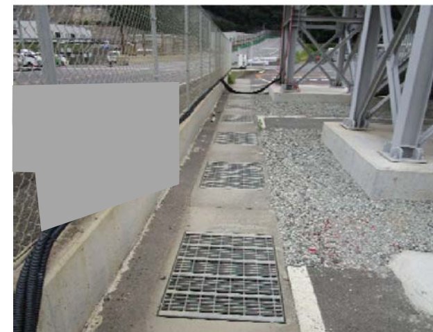
構内排水路写真(例示)
