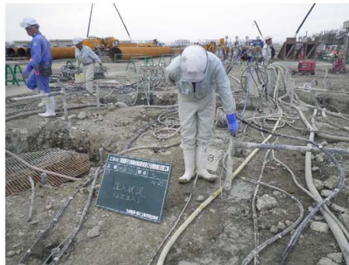
薬液注入工 状況写真(2011年撮影)
