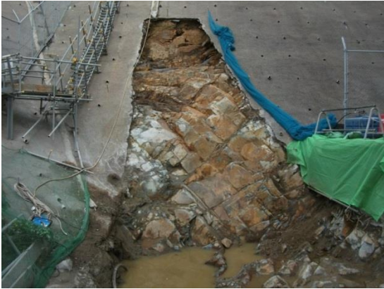
防波壁東端部 岩盤露出状況
