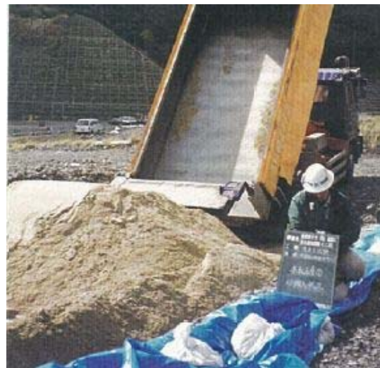
埋戻土(購入土) 現地写真(H11年)
