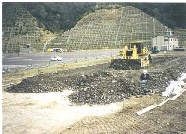
巻き出し整地状況
