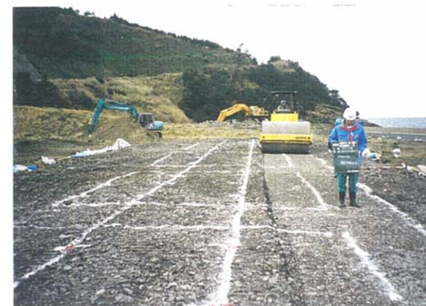
振動ローラによる転圧状況
