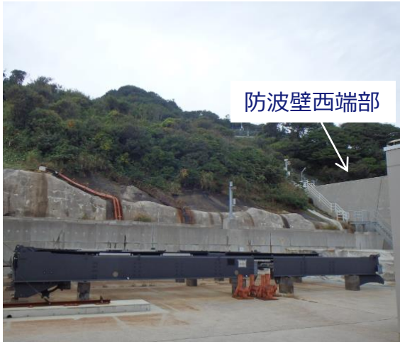
防波壁西端部 状況写真
