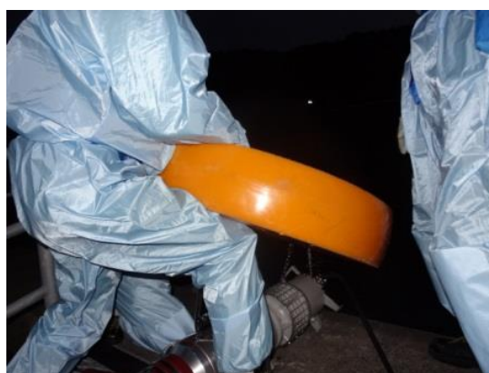
水中ポンプ設置準備（夜間）
