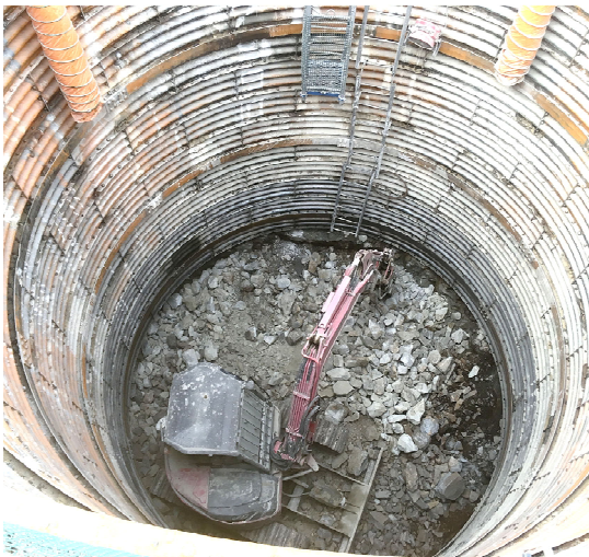
第 7. 4. 2-22 図 掘削状況写真
