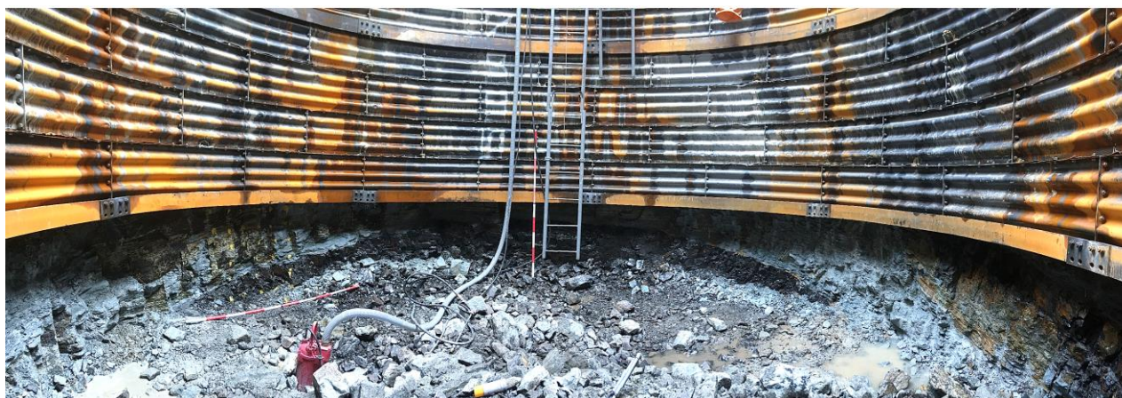
島根サイトの深礎杭 掘削面の写真（南側）
