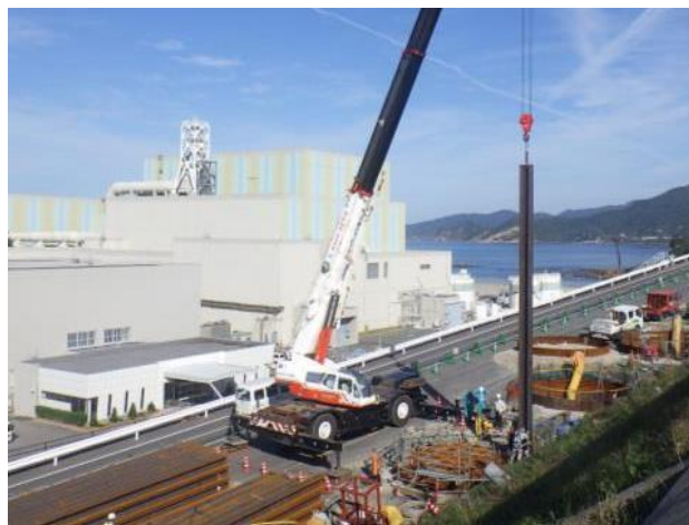
H鋼 建て込み
