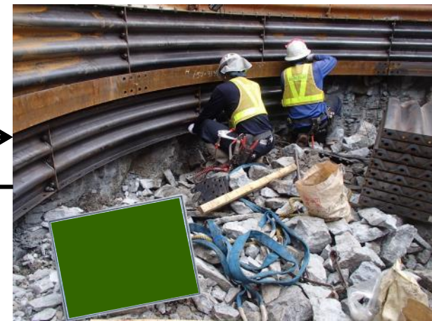
ライナープレート設置
