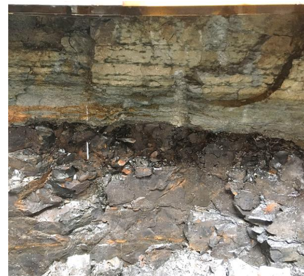
掘削面の近接写真
