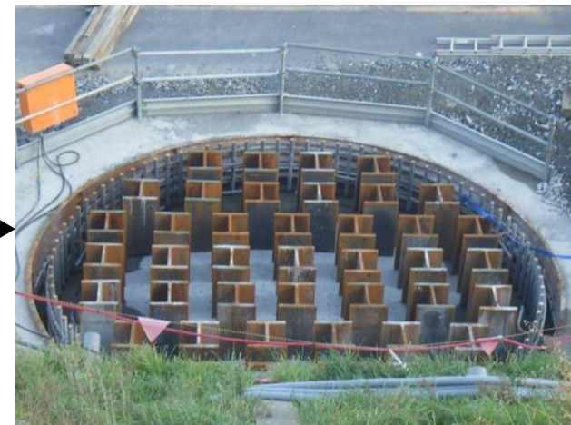
コンクリート打設後
