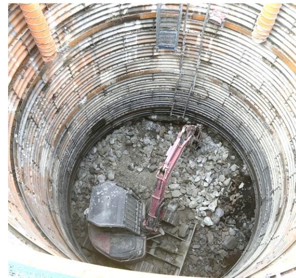
掘削状況写真
