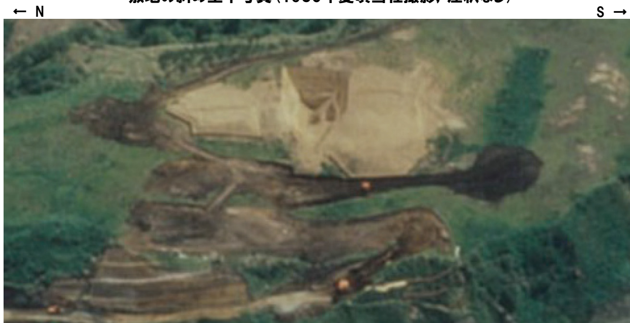
F-1断層開削調査箇所付近拡大図(注釈なし)
