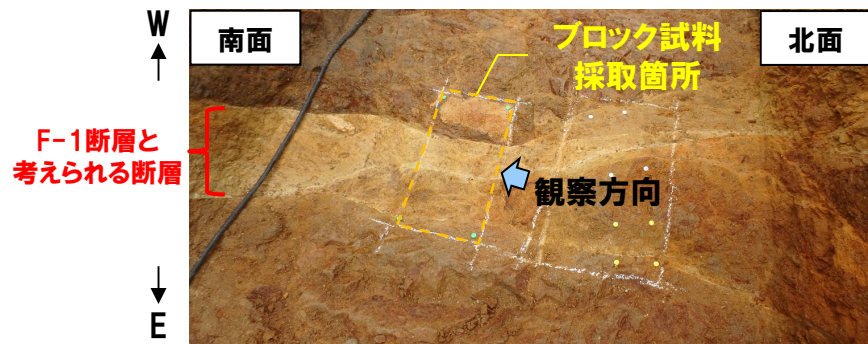
底盤写真(近景)
