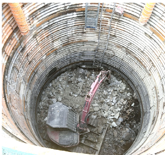
第 7. 4. 2-21 図 掘削状況写真
