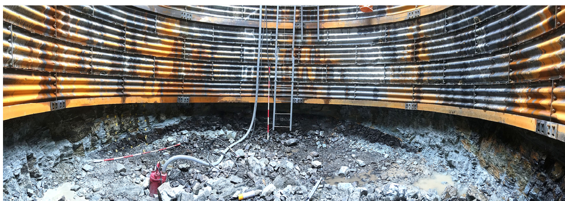
第 7. 4. 2-20 図 島根サイトの深礎杭 掘削面の写真 (南側)
