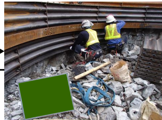
ライナープレート設置
