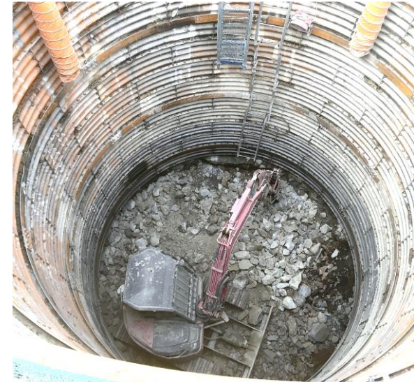
掘削状況写真
