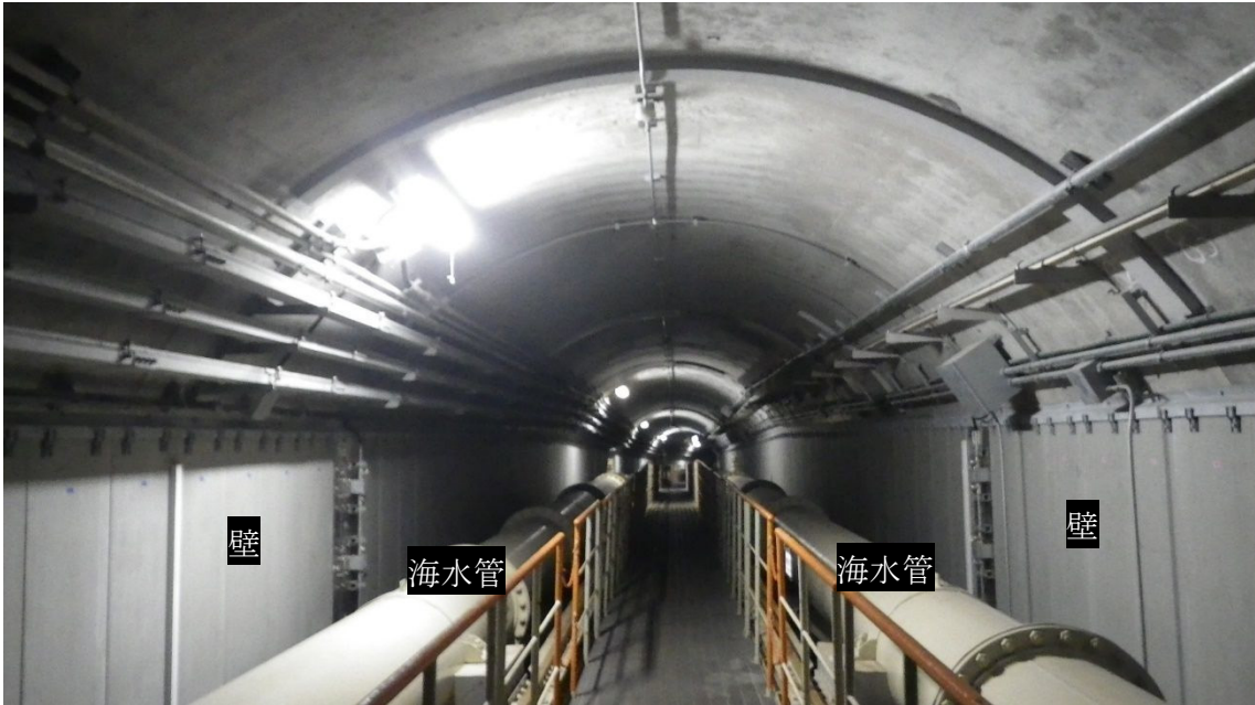
第 3-3-2 図 海水管トンネルエリアの写真イメージ
