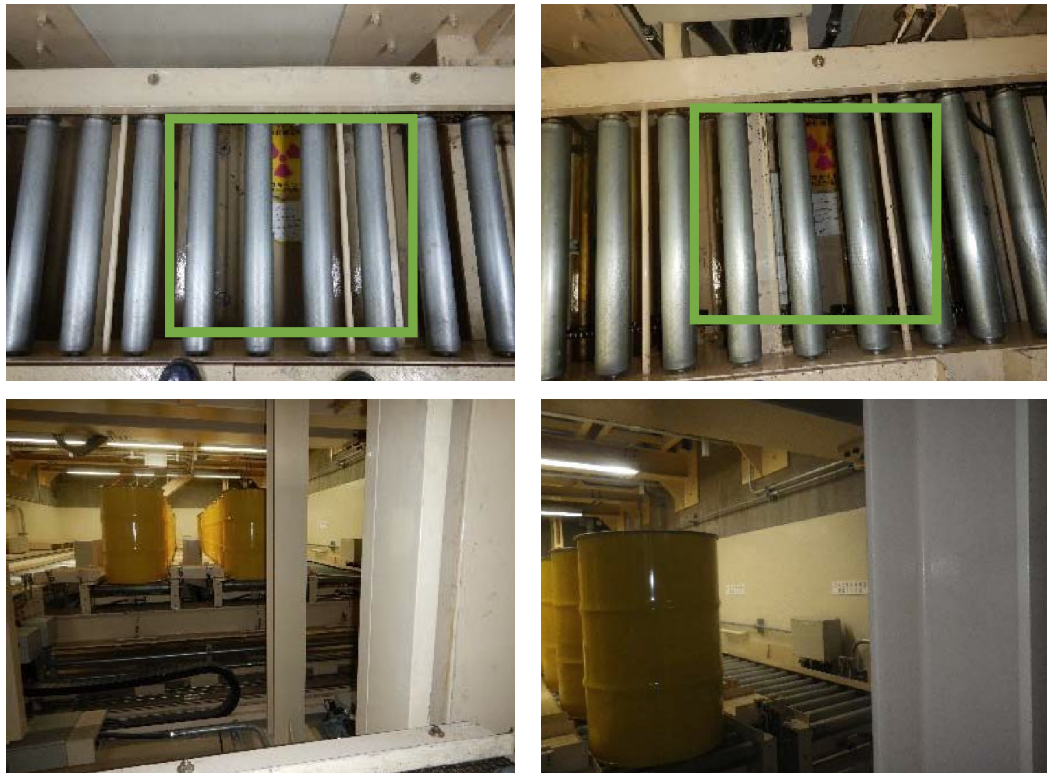
当該エリアの上部（隣接エリア）の開口部付近現場写真
