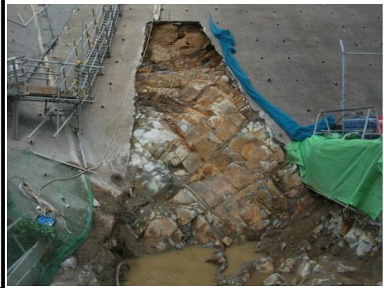
防波壁東端部 岩盤露出状況
