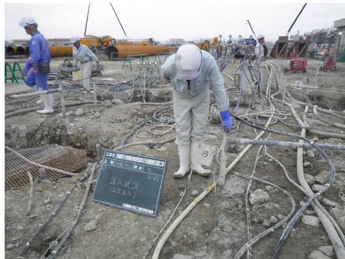
薬液注入工 状況写真(2011年撮影)
