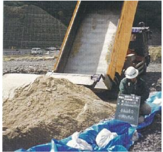
埋戻土(購入土) 現地写真(H11年)
