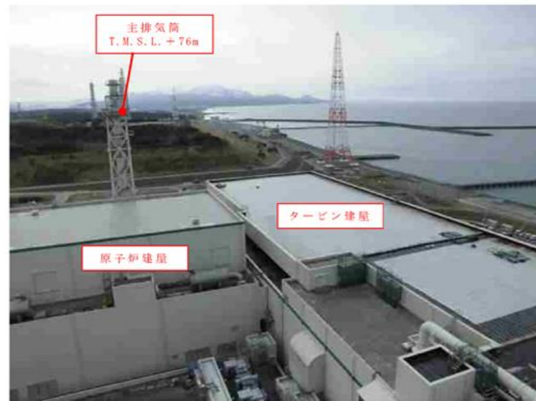
第4.3-2図 津波監視カメラ設置位置
