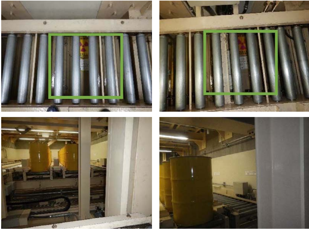
当該エリア入口付近の現場写真
