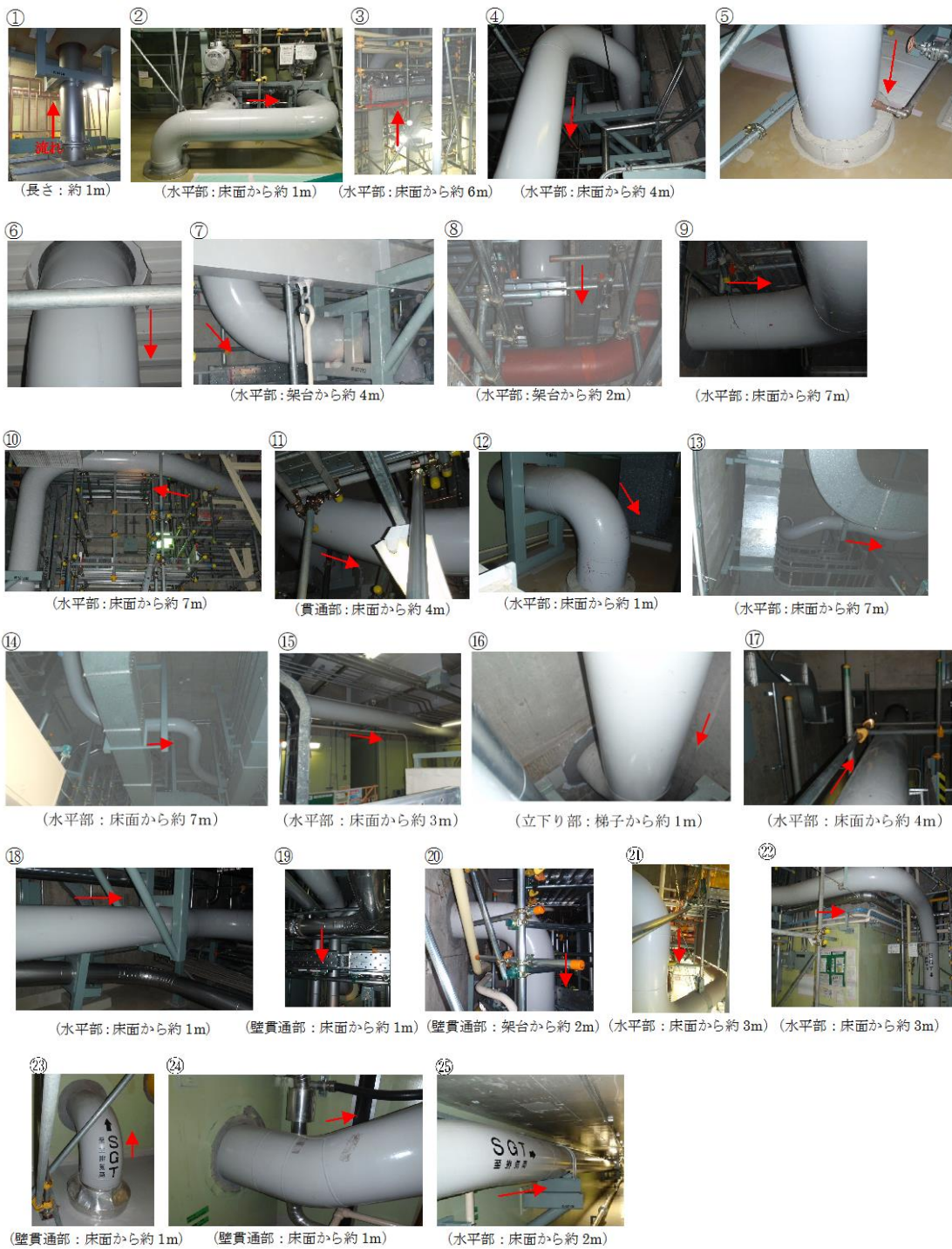
別紙図 1-9-1-2 配管敷設状況
