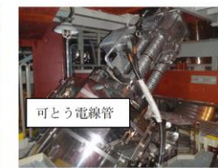
機器へのケーブル取合 (主蒸気内側隔離弁との取合)
