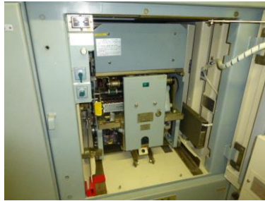
気中遮断器の例 (ロードセンタ)
