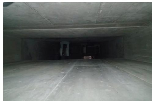
B-給気消音器フィルタ室内
