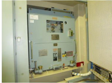
真空遮断器の例 (メタクラ)
