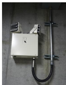
消火用非常照明 (壁掛け型) の設置例
