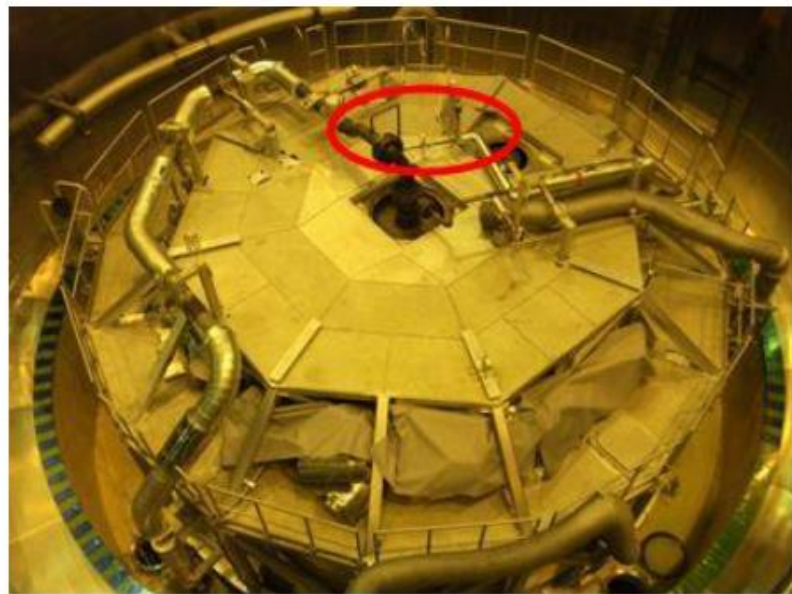
第1-9図：ベント配管の設置例
