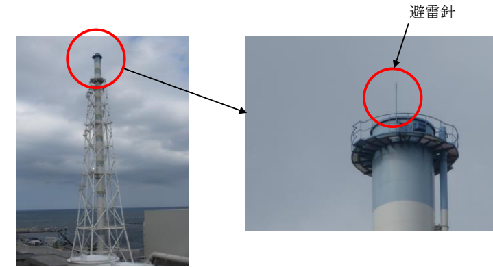
第 1-15図 避雷設備の設置例（排気筒）
