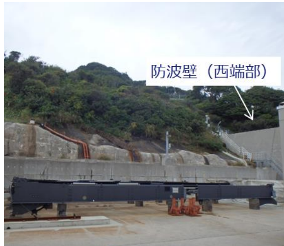
図 2 - 21 防波壁西端部 状況写真
